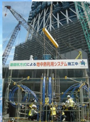
基礎杭方式 施工: 大成建設
