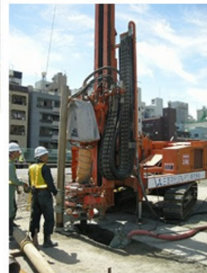
ボアホール方式 施工: 大林組 (三菱マテリアルテクノ)
