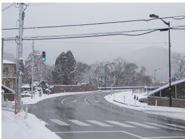
施工：日本地下水開発(株)
